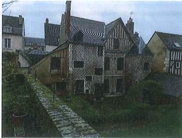
*Bâtiment remplissage moellons enduits, autrefois couvert en petite tuile plate de terre cuite, modification des ouvertures sur jardin*
